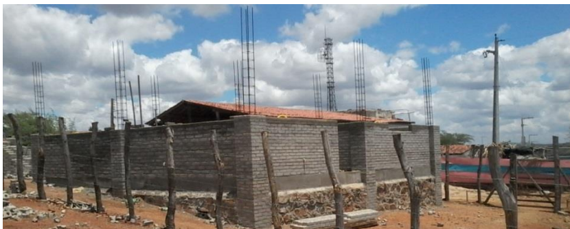
Figura 3. Vista lateral da construção da eco residência.
