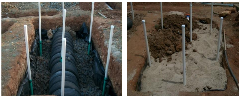
Figura 4. Início do preenchimento do tanque.
