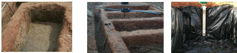
Figura 1. Escavação dos tanques evaporímetros, instalação da lona e ligação com a caixa d'água.
