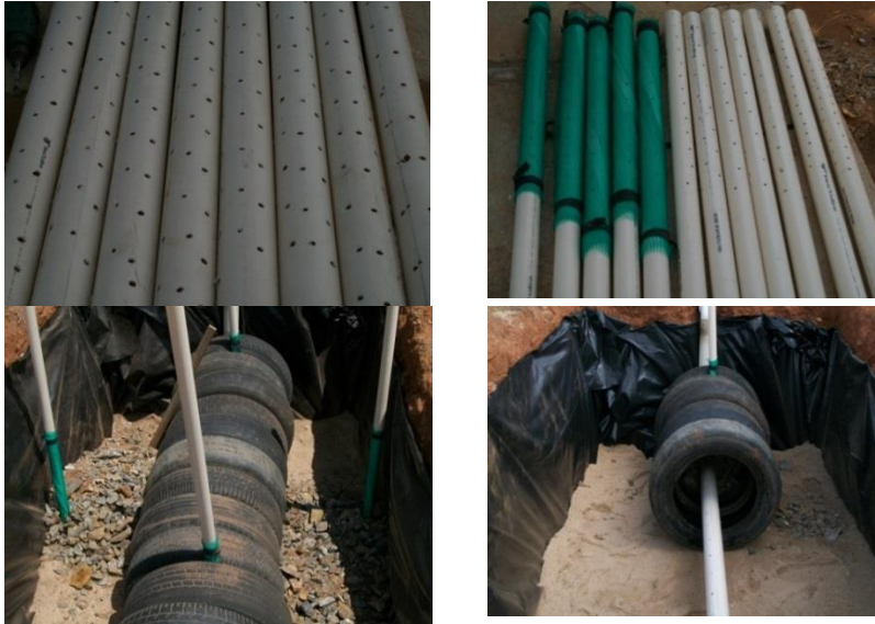
Figura 2. Tubos de PVC perfurados e a montagem dos tanques instalando os tubos e os pneus.
