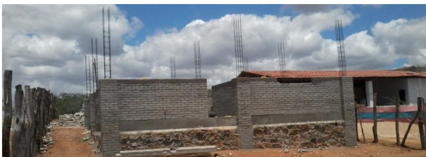
Figura 4. Vista dos fundos da construção da eco residência.
