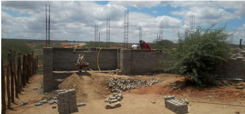
Figura 2. Vista frontal da construção da eco residência.
